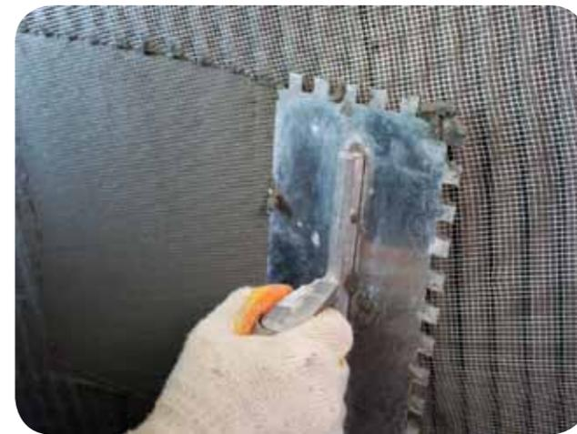
и заглаживается таким образом, чтобы сетка находилась в середине базового слоя.
