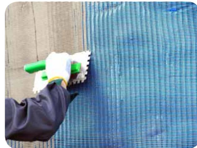
укладывается на свеженанесенный штукатурный слой, «втапливается» в него и заглаживается таким образом, чтобы сетка находилась в середине базового слоя.
