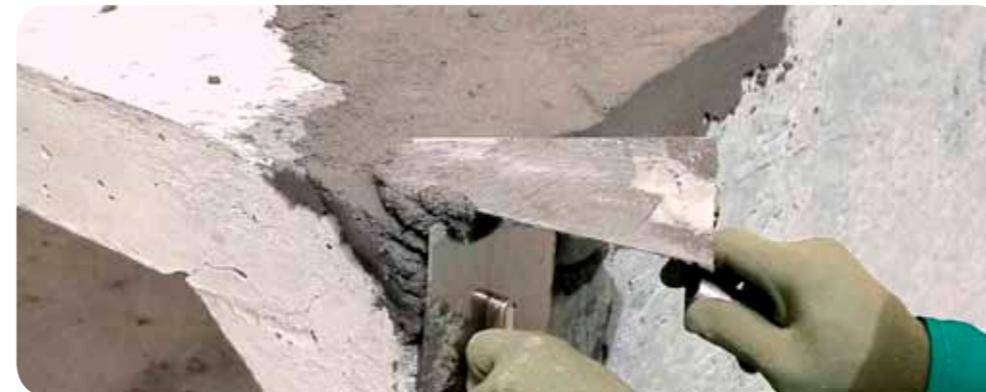
влажное основание, а затем постепенно нанести желаемую толщину. При ручном способе нанесения раствор наносится слоем в пределах указанного диапазона, от 3 до 40 мм, кистью или шпателем. Минимальная прочность, достаточная для ходьбы по поверхности, достигается через 3 часа. В процессе работы и в последующие два дня температура воздуха и поверхности основания должна быть не ниже +5°C и не выше +30°C, влажность воздуха в помещении не должна превышать 70%.
