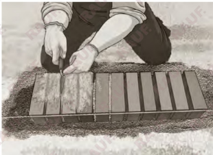
Швы заполняются слоем раствора. Свежий раствор удаляется с поверхности камней мокрой щеткой.
