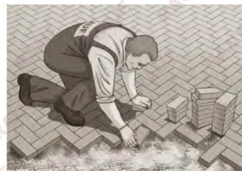
Мощение поверхности с формированием узора «елочка».
