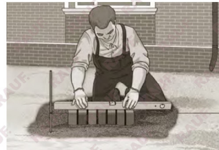
Бордюр формируется укладкой клинкера на ребро. Возможны и другие варианты: установка клинкерных кирпичей на тачок (вертикально) или использование специальных бордюрных камней.
