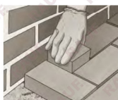
Укладка очередных рядов клинкерной брусчатки.
