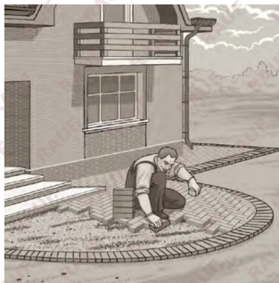
Укладка очередных рядов клинкерной брусчатки.
