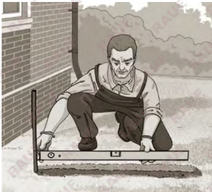
Слой раствора под бордюр раскладывается по разметке с учетом уклона 1,5-2%.
