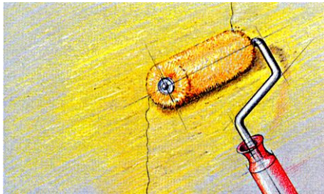
Рис. 23. Нанесение грунтовки и фасадной краски на основание.
