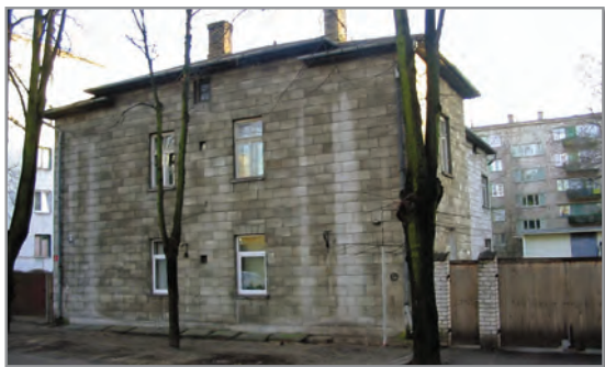
Здание из автоклавного газобетона без наружной отделки. 1939 г.п., г. Рига, ул. Эльвирас, 15
