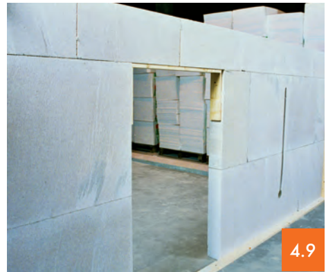
Рис. 4.7. Виды перемычек из блоков AEROC
