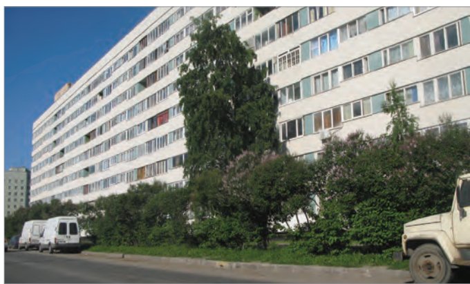
Наружные стены из автоклавного газобетона. «Корабль», 1970-е, Санкт-Петербург.
